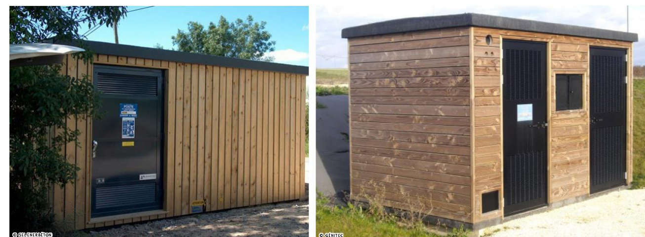
Figure 192 : Exemples de postes de livraison en bardage bois (source : ATER Environnement, 2019)
